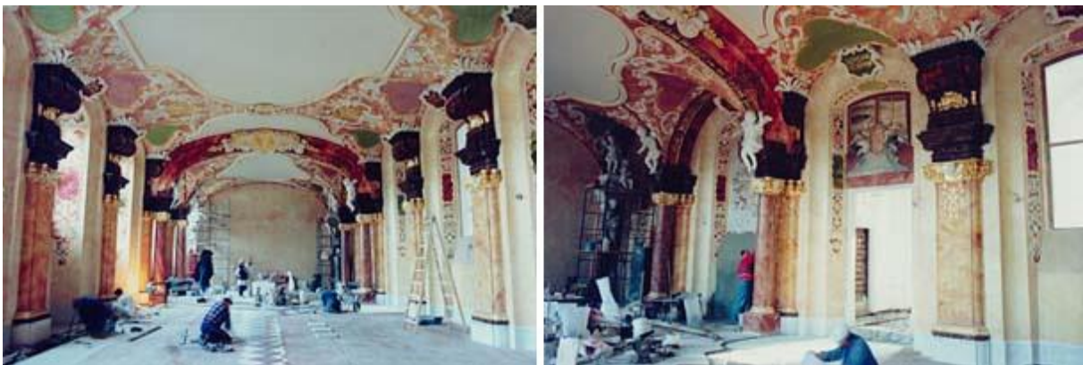
Wiederherstellungsarbeiten im Oratorium Marianum, Oktober 1997 (BA)
